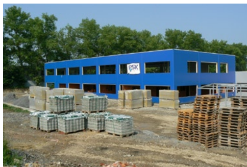
Stavba v polovině
